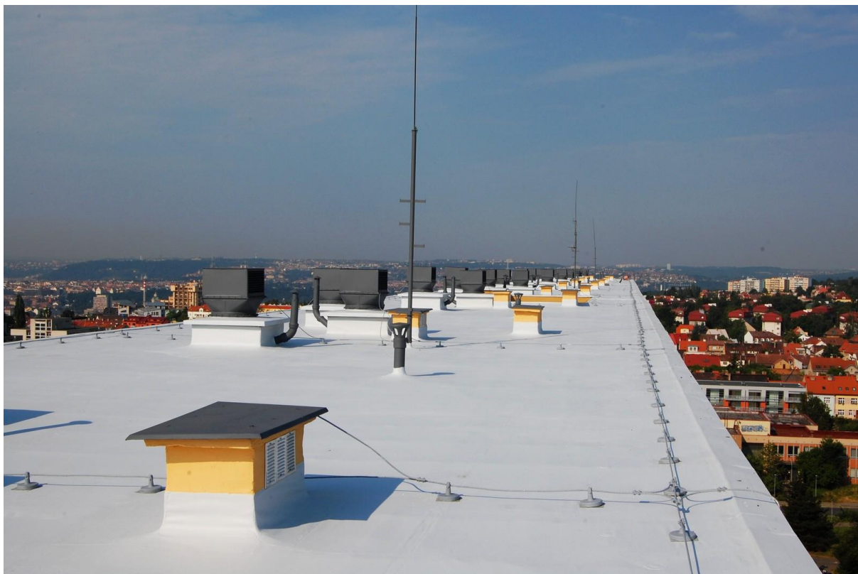
Panelový dům Praha
