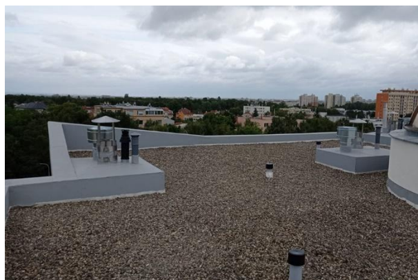
Rekonstrukce střešního pláště PVC folie Protan G 1,5 mm SV Šimůnkova v Praze
