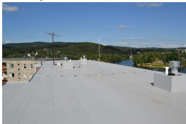
Rekonstrukce střešního pláště PVC folie Protan SE 1,6 mm Jablonec nad Nisou
