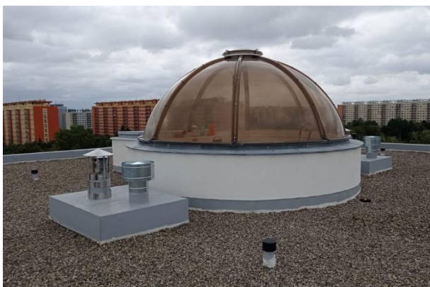
Rekonstrukce střešního pláště PVC folie Protan G 1,5 mm SV Šimůnkova v Praze
