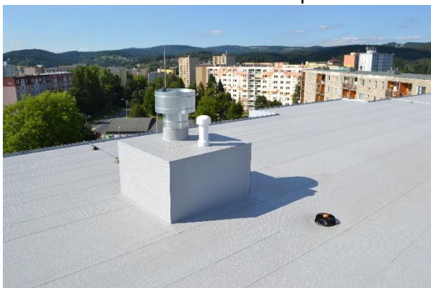
Rekonstrukce střešního pláště PVC folie Protan SE 1,6 mm Jablonec nad Nisou
